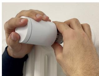
5) Installare la valvola termostatica smart TRV+AA avvitando la ghiera al filetto dell'adattatore (o a quello della valvola) in senso orario.
