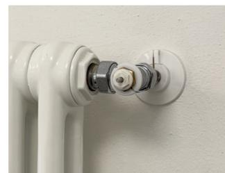
2) Installa l'adattatore se necessario. Per individuare l'adattatore corretto contattare l'idraulico di riferimento. Se necessario per l'installazione, rimuovere il cilindro di plastica presente sul fondo della TRV+AA facendolo scorrere verso l'esterno.
